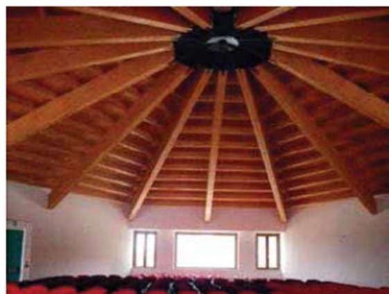
Vista interna - dettaglio copertura in legno lamellare
