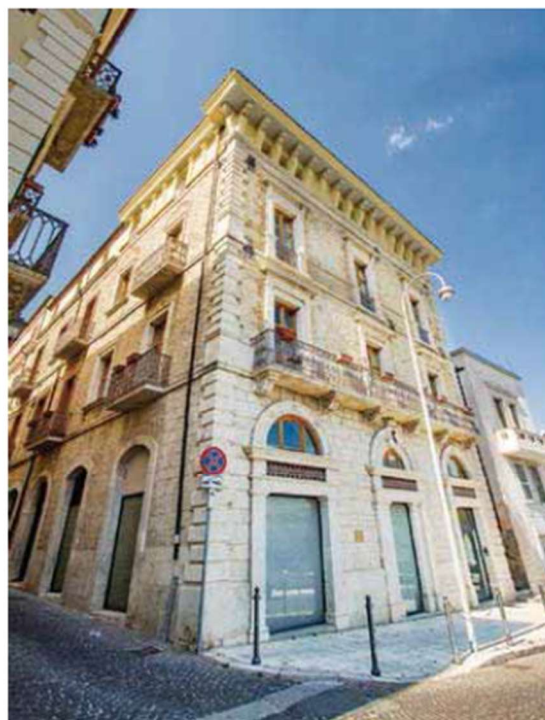
Vista esterna - prospetto principale
