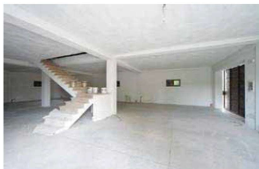
Vista interna - Fasi di lavoro
