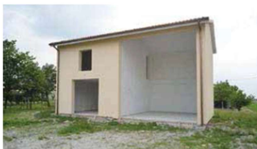
Vista esterna - retro - Fasi di lavoro
