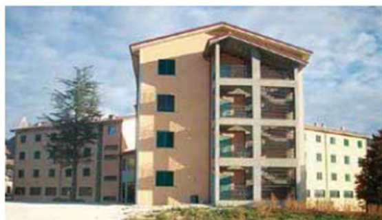
Vista esterna - prospetto principale
