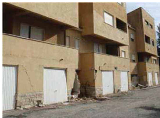
Vista esterna Lotto 5 (pre intervento)
