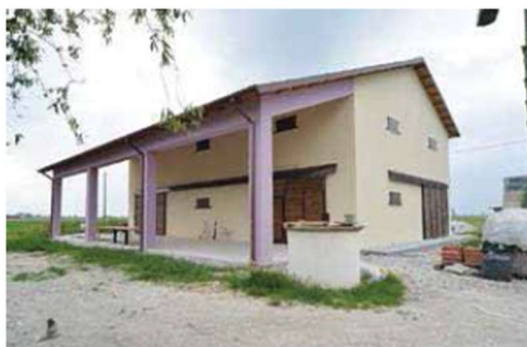
Vista esterna - prospetto principale
