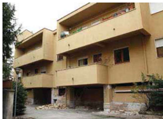
Vista esterna Lotto 3 (pre intervento)
